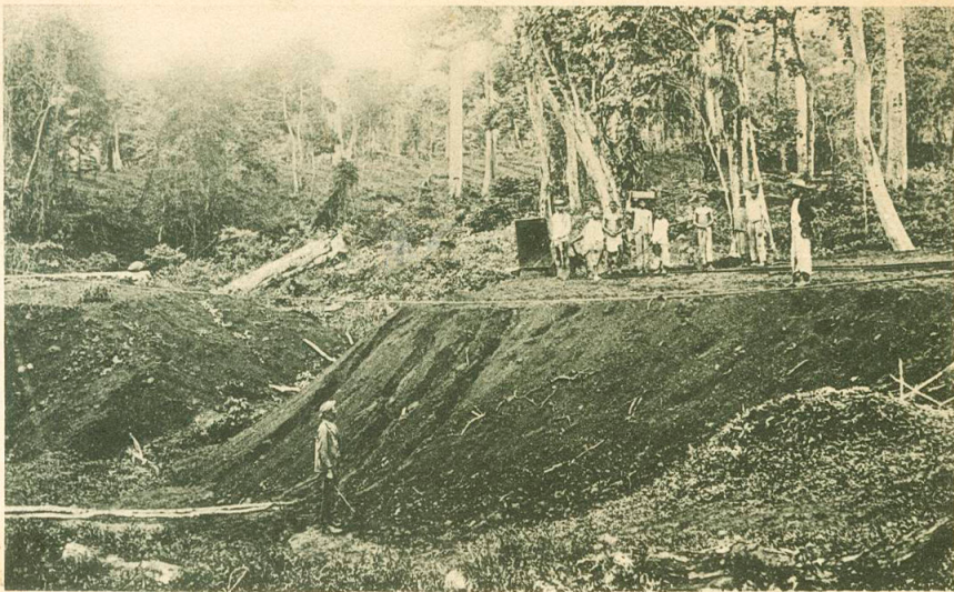
Trabajos en el camino de San Carlos
